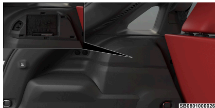
Centro de distribución de energía trasero
