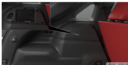
Centro de distribución de energía trasero
