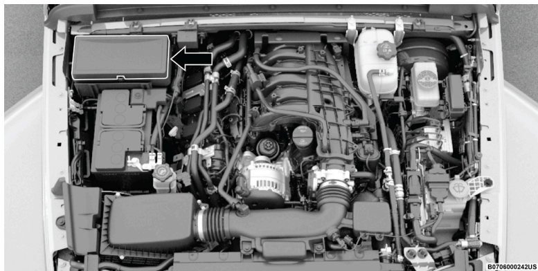
Centro de distribución de Energía
