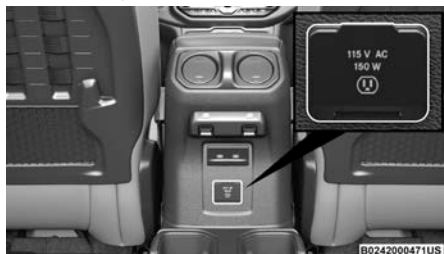
Inversor de corriente
