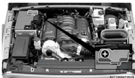
Poste positivo (+) de la batería — Motor 6.4L
