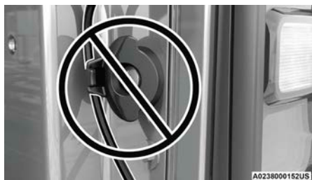
Cable de la compuerta trasera asentado incorrectamente
