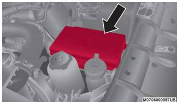
Localización del centro de distribución de energía
