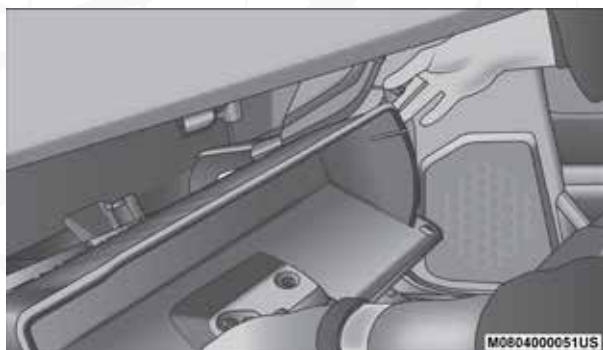
Instalación de la guantera
