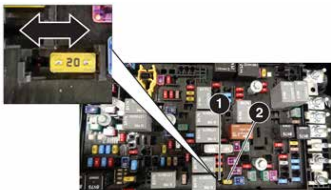
Localización de los fusible de las tomas de corriente
