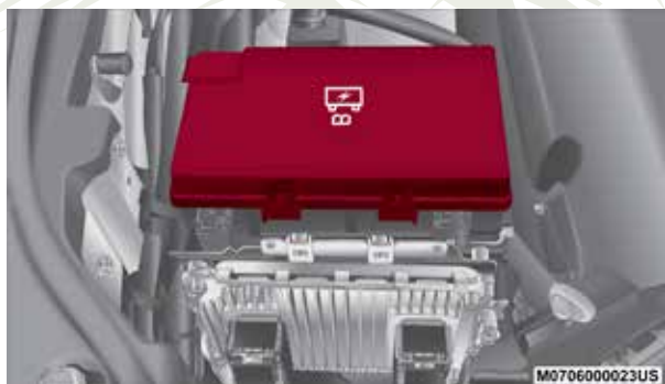
Centro de distribución de energía
