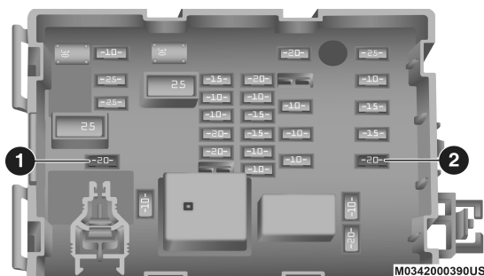
Fusibles de las tomas de corriente
